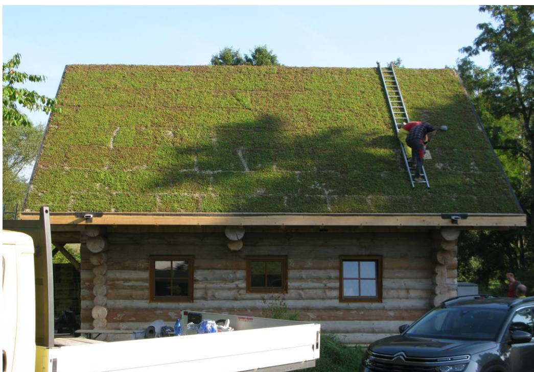
Foto 3 a 4: Založení šikmé extenzivní střechy, skladba VS4K , sklon 45°, pokládka minerální plsti a zádržného systému na strukturovanou geotextilii s drenážní a hydroakumulační funkcí a dokončená realizace šikmé střechy po doplnění spongilitového substrátu do zádržného systému a pokládce rozchodníkového koberce (foto ACRE).
