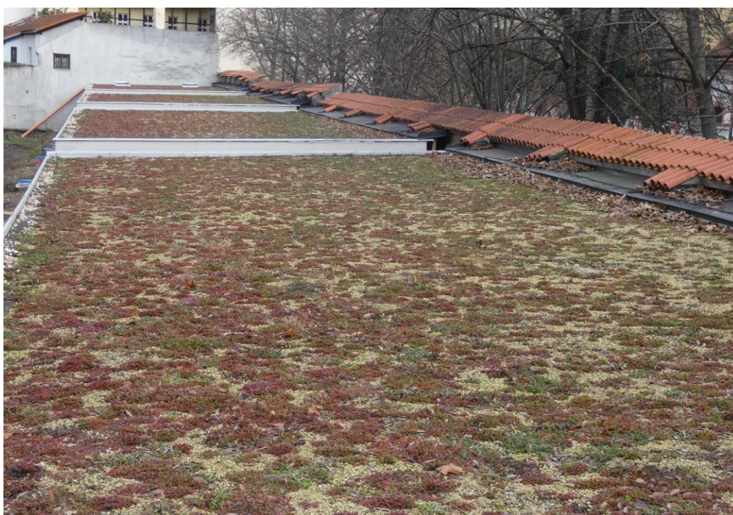
Foto 1 a 2: Extenzivní zelené střecha, modelová skladba VS2 , sklon 3 %, realizace vegetačního souvrství (ochranná geotextilie, kalíšková folie, separační geotextilie, deska hydrofilní minerální plsti a spongilitový substrát) a zapojení porostu (leden 2022) 6 měsíců po založení vegetace řízky rozchodníků (foto ACRE a H. Šimová).
