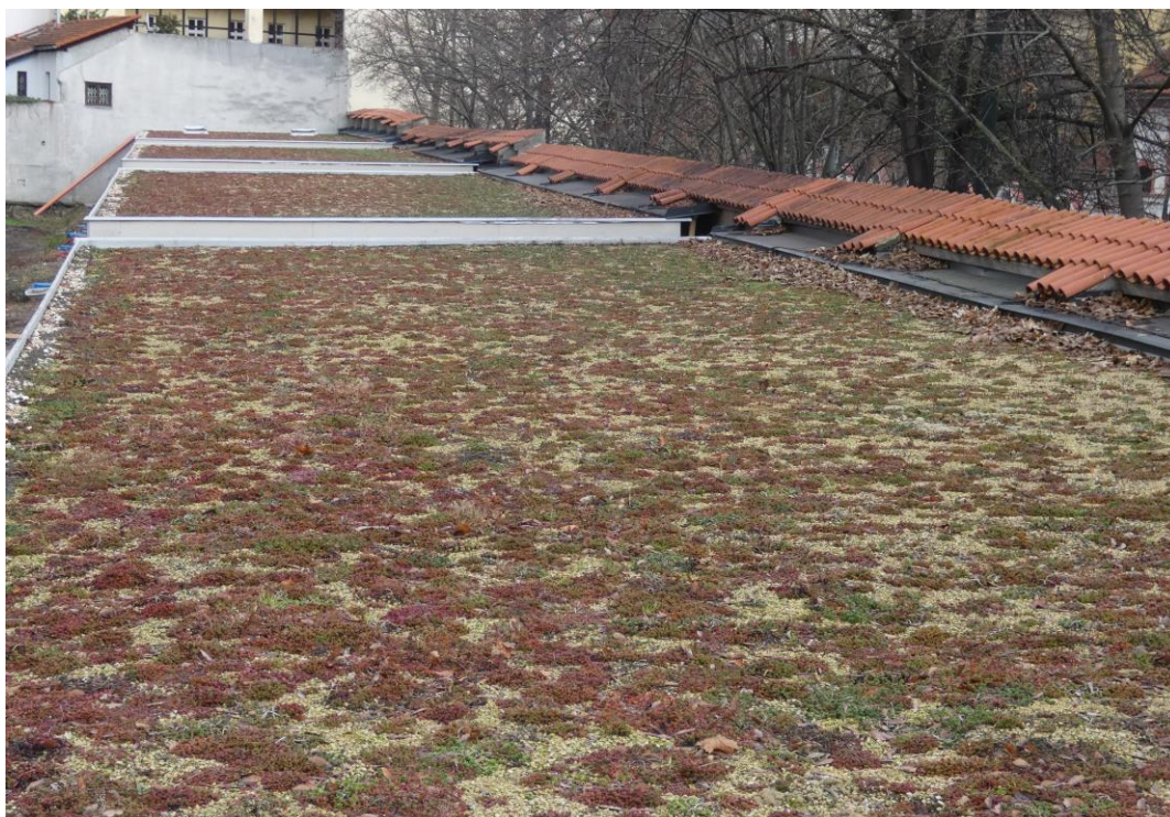
Foto 1 a 2: Extenzivní zelené střecha, modelová skladba VS2 , sklon 3 %, realizace vegetačního souvrství (ochranná geotextilie, kalíšková folie, separační geotextilie, deska hydrofilní minerální plsti a spongilitový substrát) a zapojení porostu (leden 2022) 6 měsíců po založení vegetace řízků rozchodníků (foto ACRE a H. Šímová)
